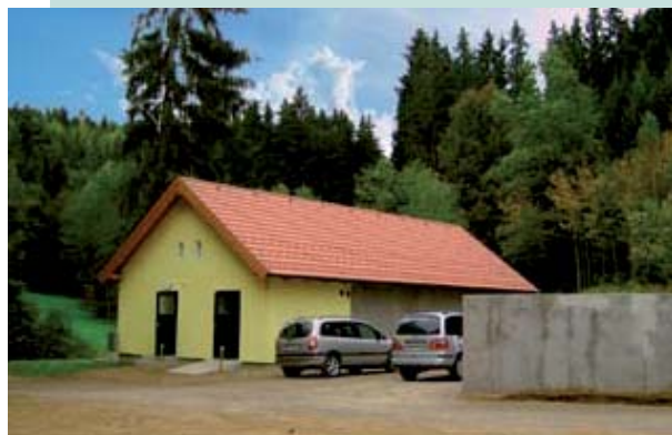
Kläranlage Schloss Rosenau 500 EW
