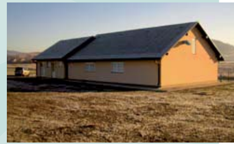
Kläranlage Brinje 1.220 EW
