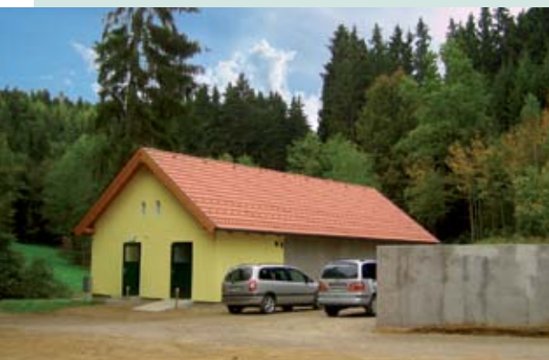
Oczyszczalnia ścieków Zamek Rosenau 500 RLM
