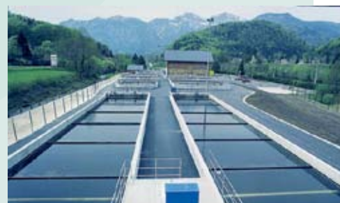
Oczyszczalnia ścieków 65.000 RLM
